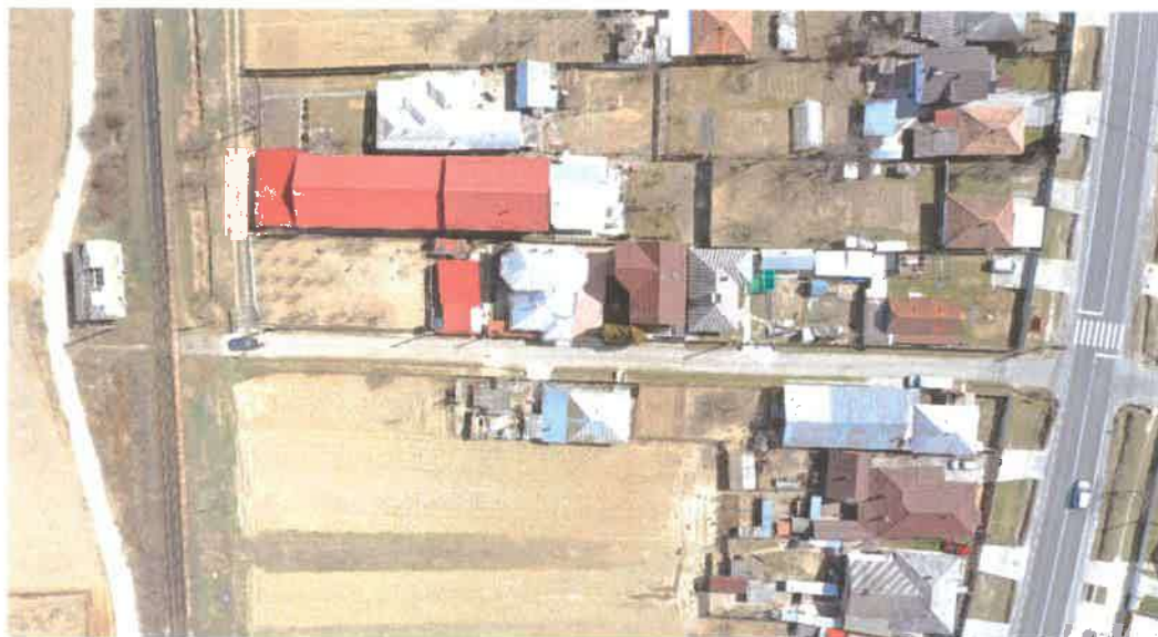
Figura 4-79. Stația Lespezi Bacău – drum acces
