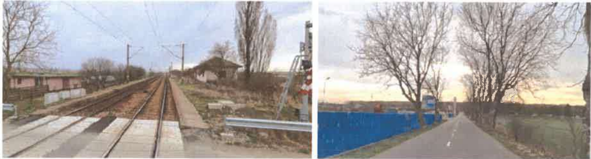
Figura 4-72. Halta Șerbești – Trecere la nivel cu calea ferată
