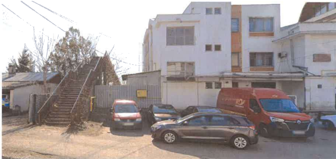
Figura 4-68. Gara Bacău – pasarelă pietonală
